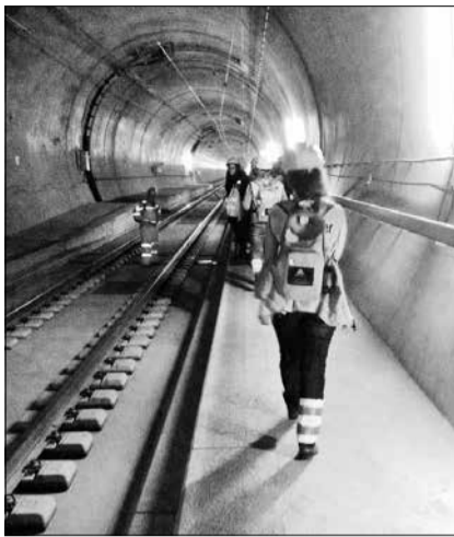
Die Neat-Tunnelbesichtigung (Bild links) bot den Basler Studierenden einen Einblick in ein gigantisches Projekt. In Andermatt (Bild rechts) erhielten sie Einsicht in die Konzeption des Resorts von Samih Sawiris. FOTOS: ZVG
